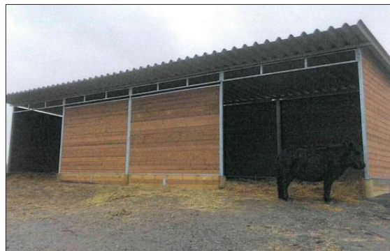
Voorwanden gemonteerd in schuilstal
