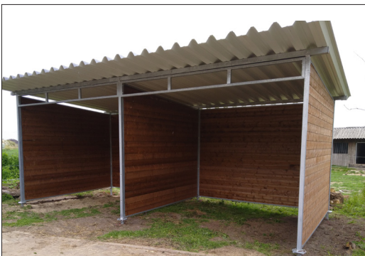
Scheidingswand gemonteerd in schuilstal
