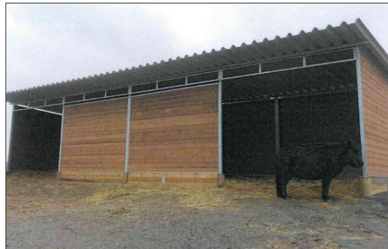
Voorwanden gemonteerd in schuilstal
