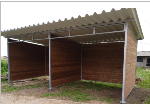
Scheidingswand gemonteerd in schuilstal
