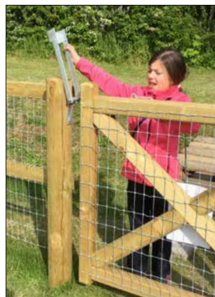
De Country Estate poorten worden gemonteerd met gaas dat bij de omheining past. Het hang- en sluitwerk wordt aangepast aan de gekozen hekken.
