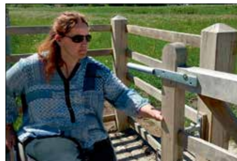
Het hek wordt geopend van positie 1 naar positie 2. Het hek sluit vanzelf, waardoor het nooit half open kan staan.
