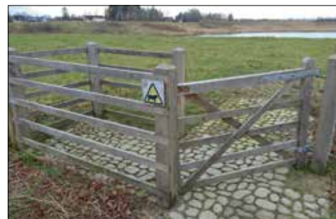
Hier staat het hek in positie 2. In deze positie zit het hek vast met een eenvoudige heksluiting.
